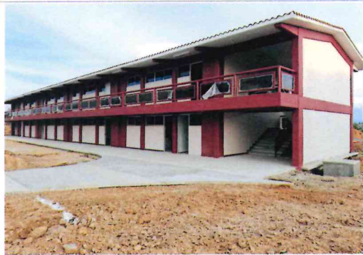
F1- FACHADA PRINCIPAL
